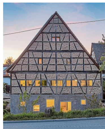
Bürolicht scheint nun hinter den neuen Fenstern einer alten Scheune in Hohenlohe.
