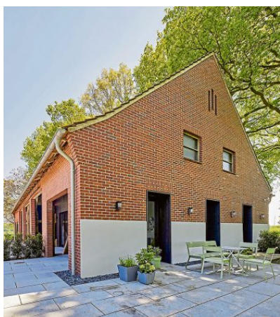
Ein neues Haus wurde in diese Scheune in Gescher gesetzt. Die Öffnungen springen zurück.
