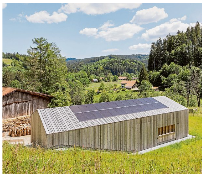
Maschinen finden in dieser neuen Halle in Isny im Allgäu Platz. Der Baukörper ist schlicht mit Holz verkleidet, die PV-Anlage bündig ins Dach integriert.
