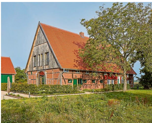
Ganz behutsam und mit viel Achtung vor der denkmalgeschützten Bausubstanz wurde dieses Bauernhaus in Ahlen umgebaut.
